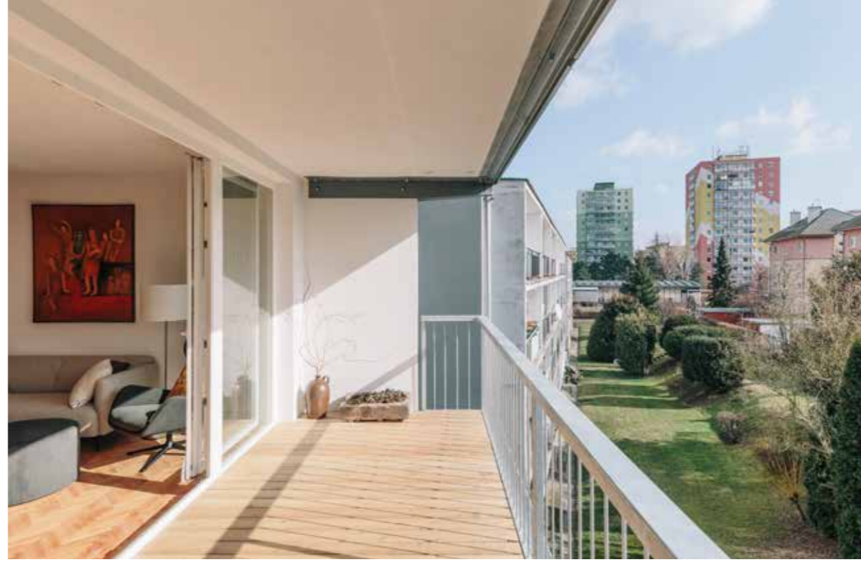
Rozšíření původních balkonů o 90 cm, rohová lodžie
