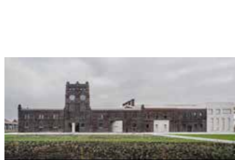
Rekonstrukce historické budovy bývalých jatek pro účely galerie Plato Ostrava / KWK Promes, MS-projekce
