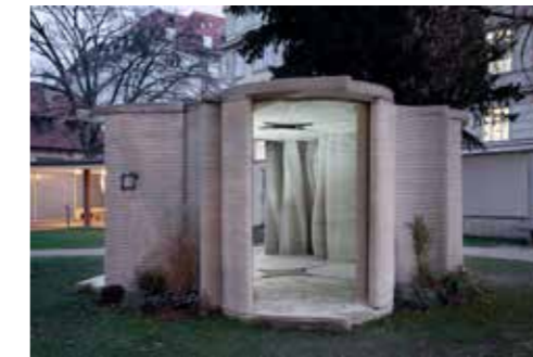
Mezi Konflikty, Praha / ICE Architects (2022)
