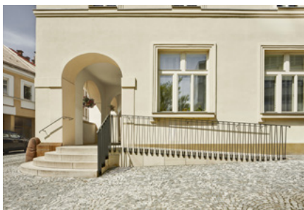
Vstup do podloubí, Trutnov
