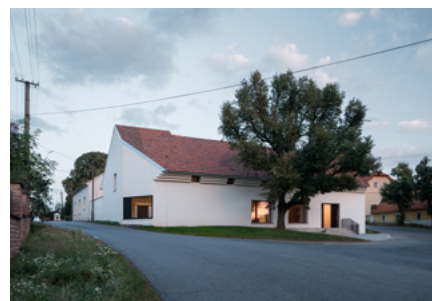
Komunitní centrum v Máslovicích
