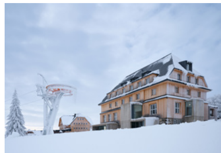
Centrum Hořec, Horní Malá Úpa
