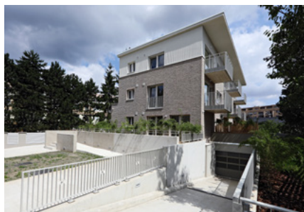
Bytový dům Podbělová, Praha 5
