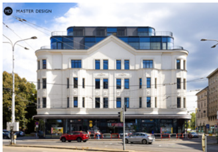
Rekonstrukce Ostravica Textilia, Ostrava
