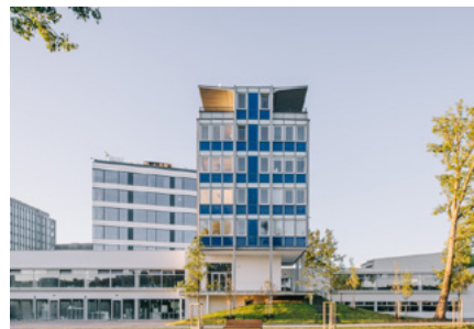
Rekonstrukce objektu Panelárna, Praha
