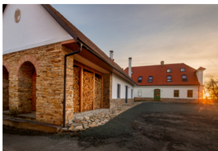
Rekonstrukce statku na sídlo firmy, Dobruška-Běštvin
