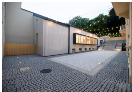
Celková rekonstrukce domu Chopin, Mariánské Lázně
