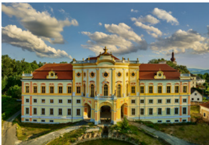
Rekonstrukce Zámku Týnec, Janovice nad Úhlavou
