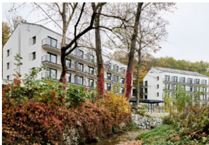
Bytový dům Hlubočepy, Praha 5
