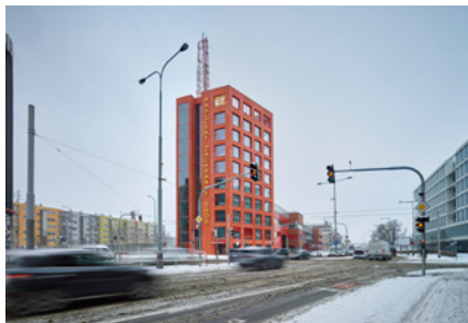
HZS hlavního města Praha – objekt B
