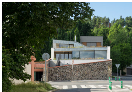
Bytový dům U Vinice, Praha 8-Troja
