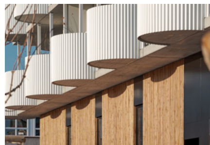
Bytový dům u Borského parku, Plzeň
