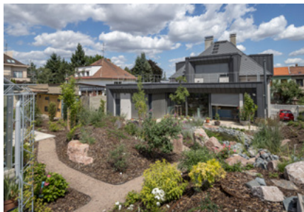
Dům s přístavbou, Roudnice nad Labem
