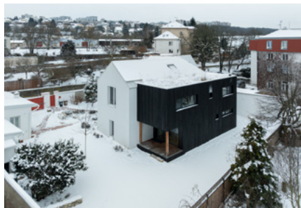
Rekonstrukce domu, Praha-Hlubočepy
