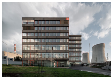
Školící, administrativní objekt AB3, Dukovany
