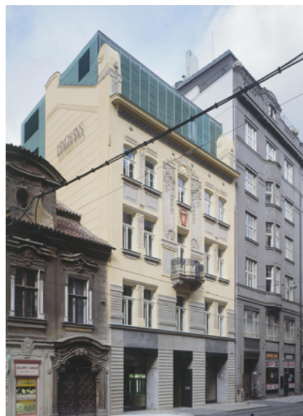
Rekonstrukce paláce Langhans, Praha, 2002
