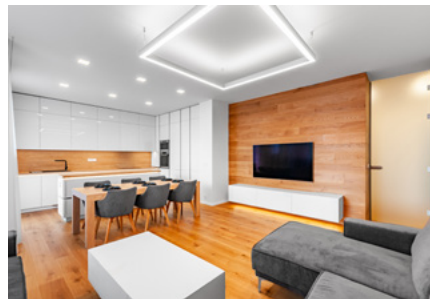
Rekonstrukce bytu Vršovice, Praha
