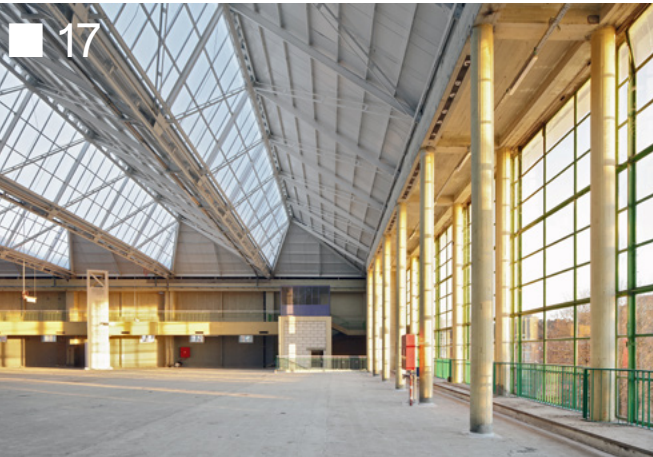
Rekonstrukce výstavního areálu Charleroi Palais v Belgii, autoři: AgwA; architekti Jan de Vylder Inge Vinck
