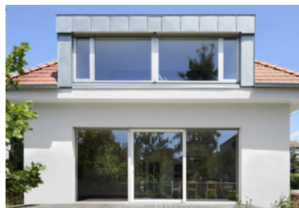
Rekonstrukce vily v Poděbradech
