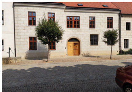
Rekonstrukce měšťanského domu, Slavonice
