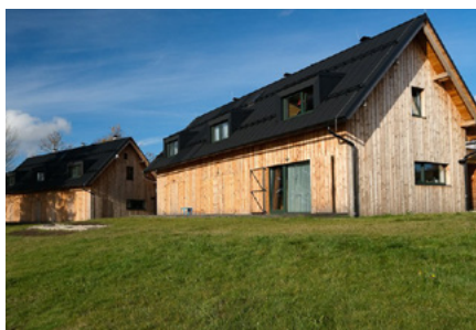
Novostavba dvou rodinných domů, Pířichovice u Kořenova
