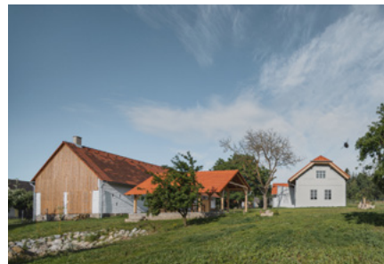
Rekonstrukce venkovské usedlosti, Hvožďany
