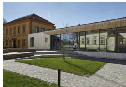
Přístavba školy v Kostelní Lhotě
