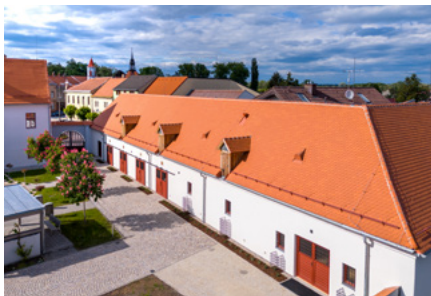
Havarijní stav objektu „konírny“, Pohořelice
