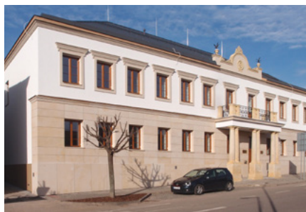
Rekonstrukce objektu Hirschovy vily, Hořice
