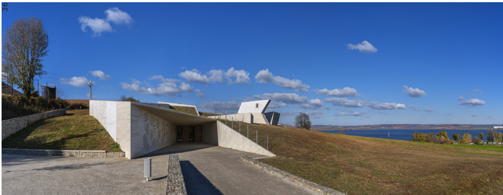
Hlavní vstup do podzemní části objektu, pohled jižní. Foto: Aleš Jungmann
