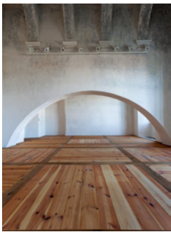
Rekonstrukce severního křídla Jezuitské koleje, Kutná Hora / Atelier M1 architekti (2014)
