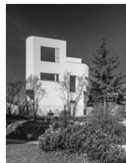
Přestavba rodinného domu pod Kraví horou, Brno / Urban Čelikovský Architekti (2016)
