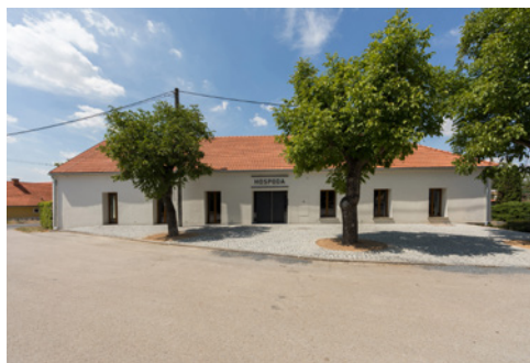
Rekonstrukce hospody se sálem, Máslovice / ATELIER BOD ARCHITEKTI (2018)
