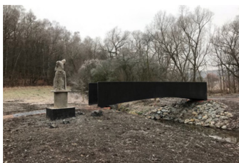
Lávka přes Dřetovický potok, Kladno-Vrapice / Aoc architekti (2018)
