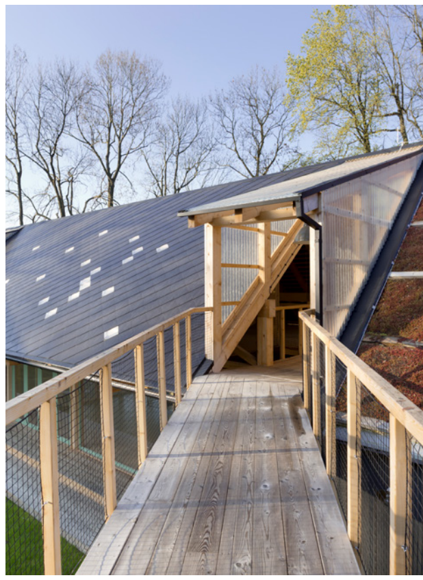
Hostinský dům – pohled z lávky na střešní krajinu
