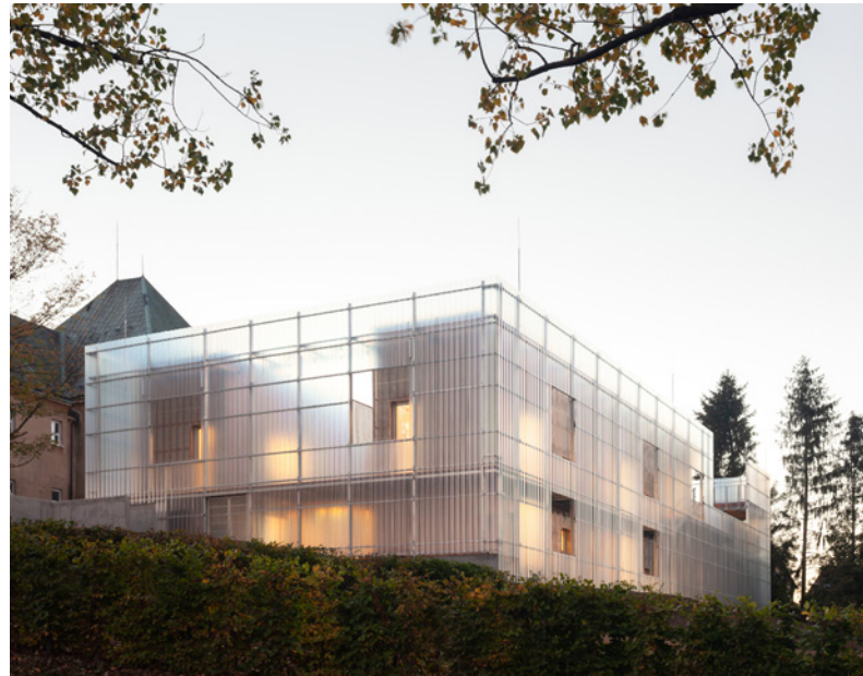
Pohled od příjezdové komunikace
