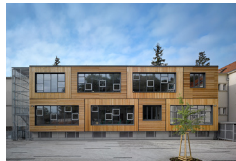
Přístavba ZŠ Praha 9-Klánovice / VYŠEHRAD atelier (2018)
