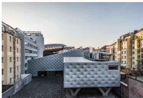
Centrum současného umění DOX+, Praha 7 / Petr Hájek ARCHITEKTI (2018)
