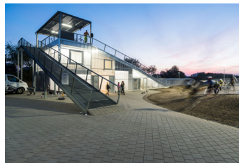
Startovací rampa BMX, Praha 8 / ARCHITEKT Ondřej Tuček (2018)
