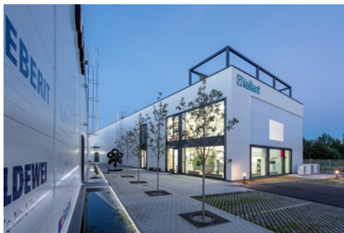
Technologický dvůr, České Budějovice / boq architekti (2018)
