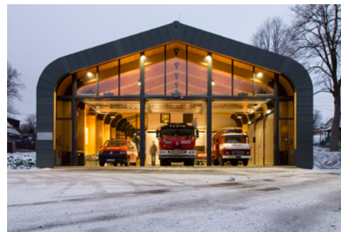
Hasičská zbrojnice, Liberec-Krásná Studánka / Vojtěch Šrut – architekt (2018)
