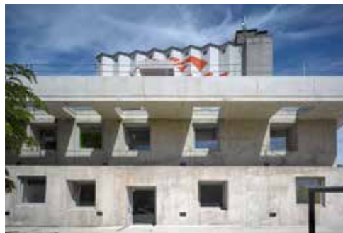
Administrativní budova ve Strančicích, Svojšovice / Architektura (2016)
