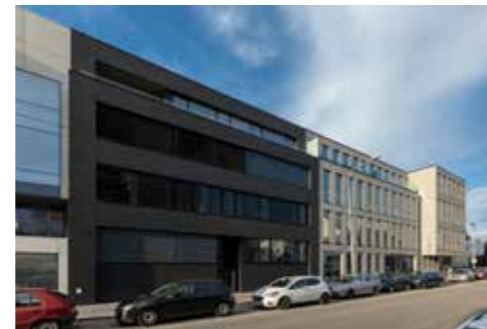
Bytový dům Kvítková, Zlín / CHLÁDEK ARCHITEKTI (2017)
