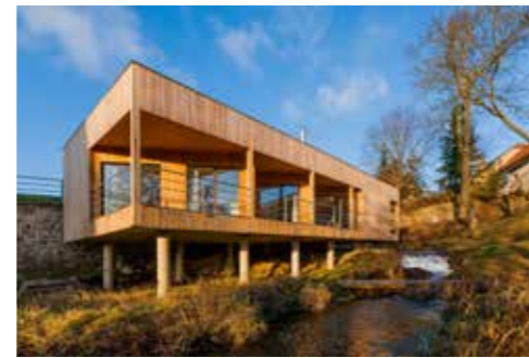
Dům nad vodopádem, Telč / ARCHOO (2015)
