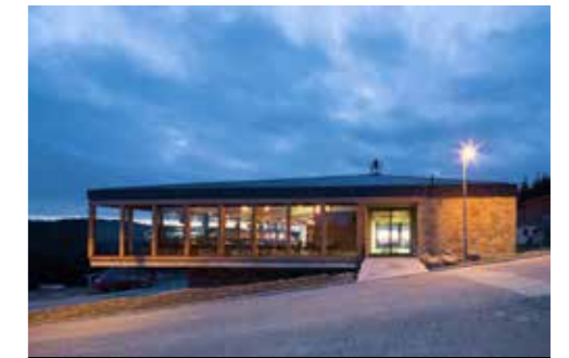
Výstupní stanice lanové dráhy na Pustevnách, Trojanovice / Kamil Mrva Architects (2017)
