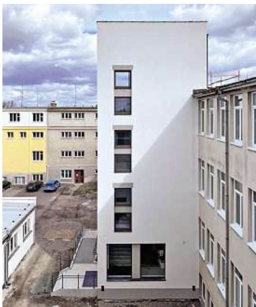
▲ Schodišťová věž ZŠ a MŠ Noe Světlík Šedý Šefl (2021) / Pardubice
