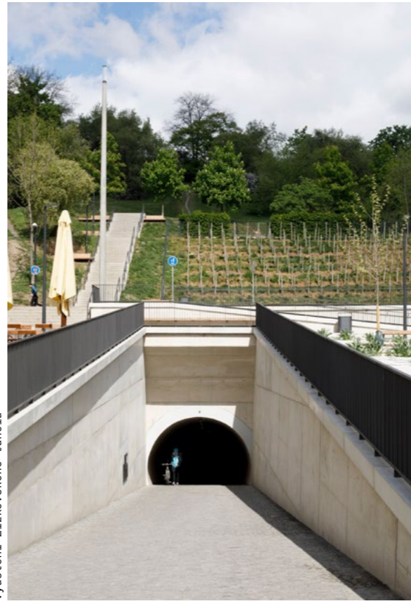
Vyústění Žižkovského tunelu
