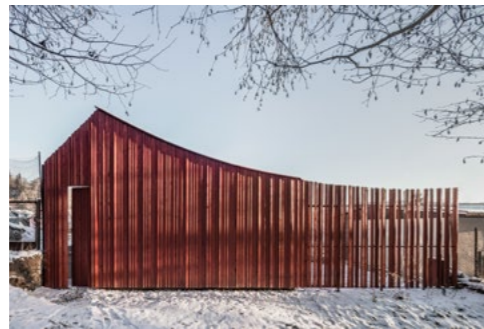
Chata nad Sušicí / BYRÓ architekti (2022)
