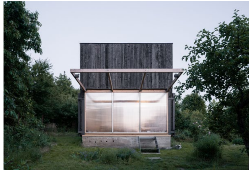
Čelní pohled - průsvitný panel
