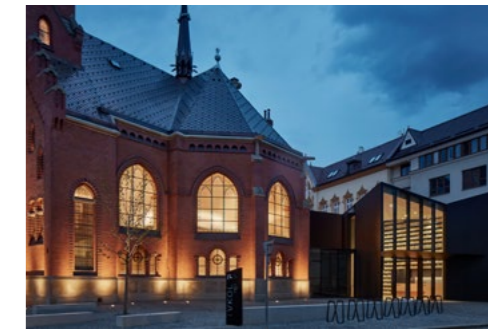
Obnova Červeného kostela, Olomouc / atelier-r (2023)
