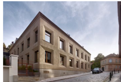
Rezidence Gotthardská, Praha 6 / Nedvěd Architekti (2023)
