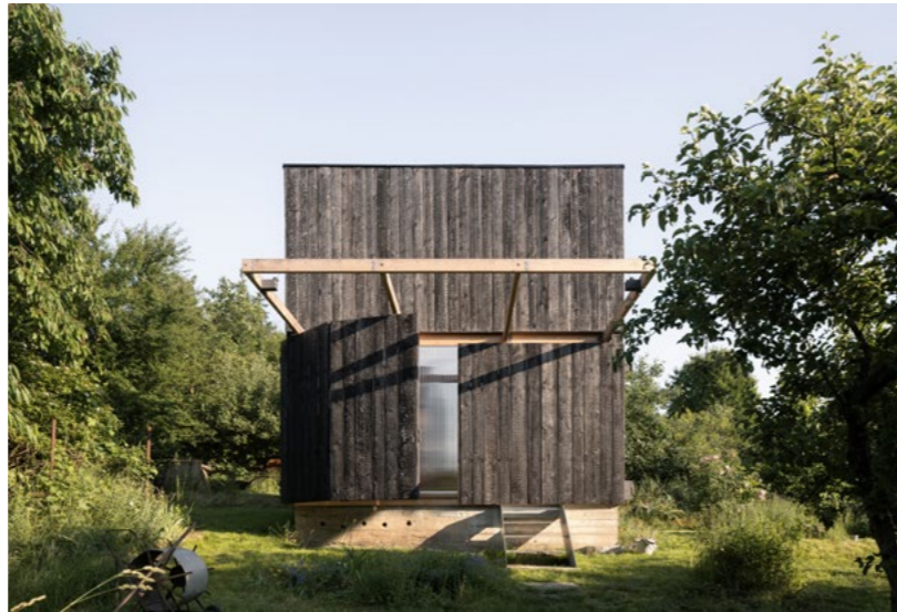
Čelní pohled - okenice
