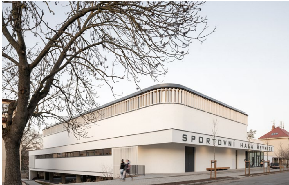
Pohled z ulice Školní
