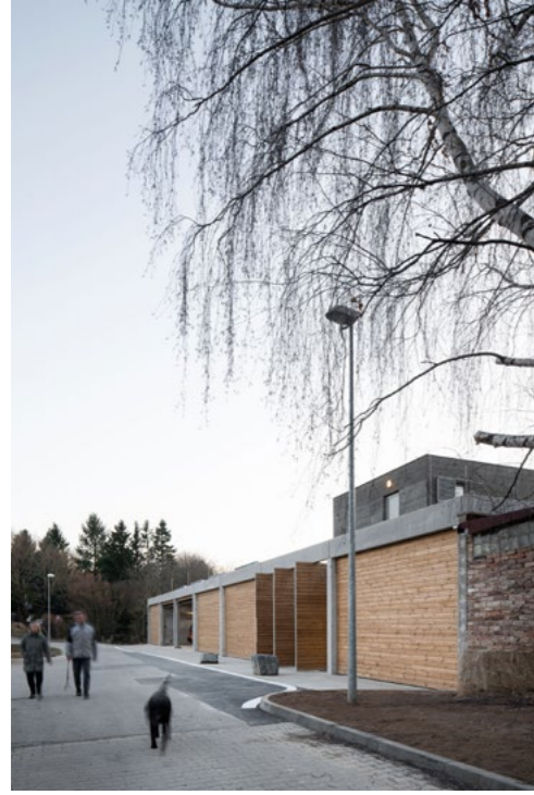
Severní pohled z ulice
