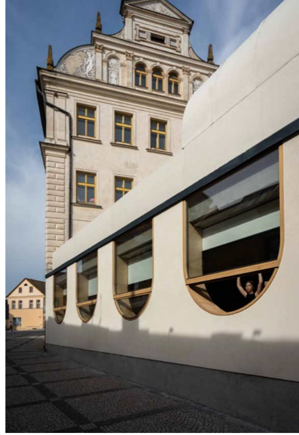
Jižní fasáda staronové přístavby
