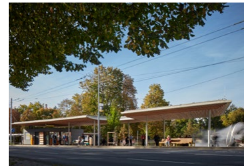
Rekonstrukce tržiště Pod Kaštany ve Zlíně/ ellement architects (2022)
